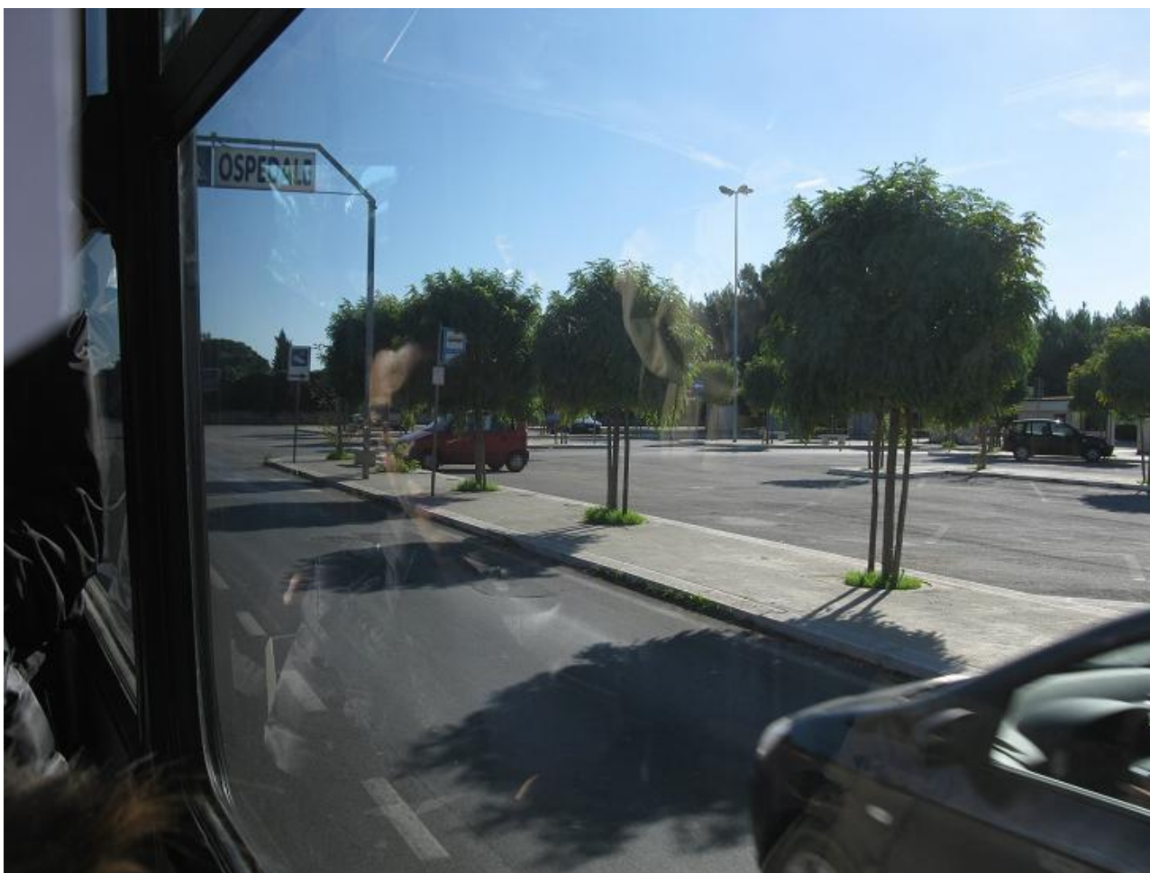
Fig.19: l'attraversamento pedonale per raggiungere l'ospedale confluisce verso un marciapiede privo dello scivolo per disabili.
