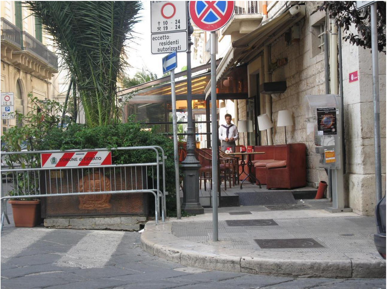
Fig.37: un marciapiede ostruito da una struttura in legno adibito a salette per consumazioni al bar.
