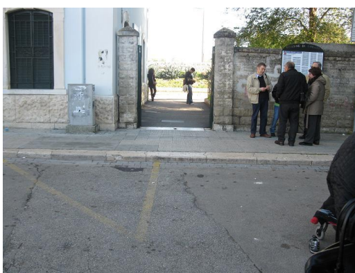
Fig.15: assenza di scivoli per disabili.
