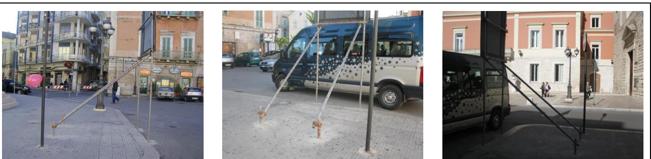
Figg.23-25: sostegni di un cartellone dei lavori pubblici senza adeguata protezione.
