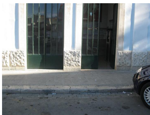
Fig.16: assenza di scivoli per disabili.
