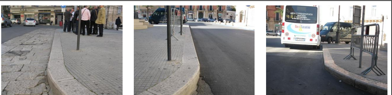
Figg.20-22: la piazzola di sosta per prendere i bus urbani è priva di scivoli.
